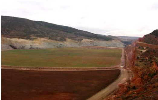
Figura 3. Restauraciones de la Corta Barrabasa, en Alloza.
