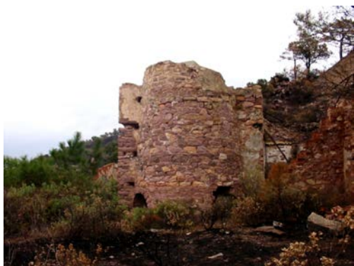
Figura 3. Hornos de tostación. Minas de mercurio de Chovar.
