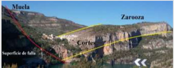
Fig. 4: Bloque hundido de Zarooza, sobre el que se asienta el pueblo.
