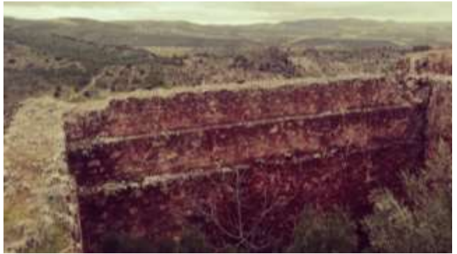
Fig. 4. Tolvas de la mina de Sierra Cabrera
