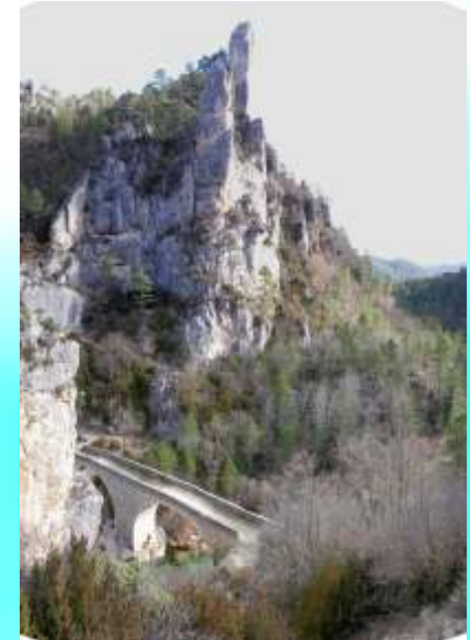
Puente de Peñalén
