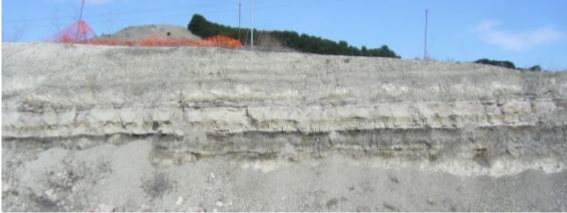
Detalle del desmonte en Zaratán, 2ª parada.
