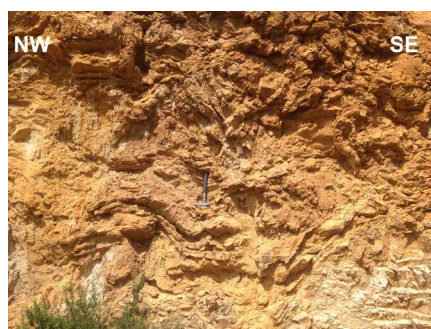
Fig. 3.- Principal afloramiento estudiado en el km 10 de la carretera C-43. Ver figura en color en la web. Fig. 3.- Main outcrop studied at km 10 of the C-43 road. See color figure in the web.
