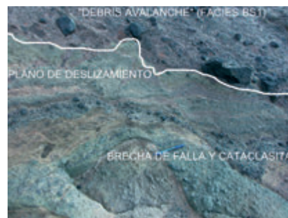
Fig. 3. - Detalle de la superficie de deslizamiento.
