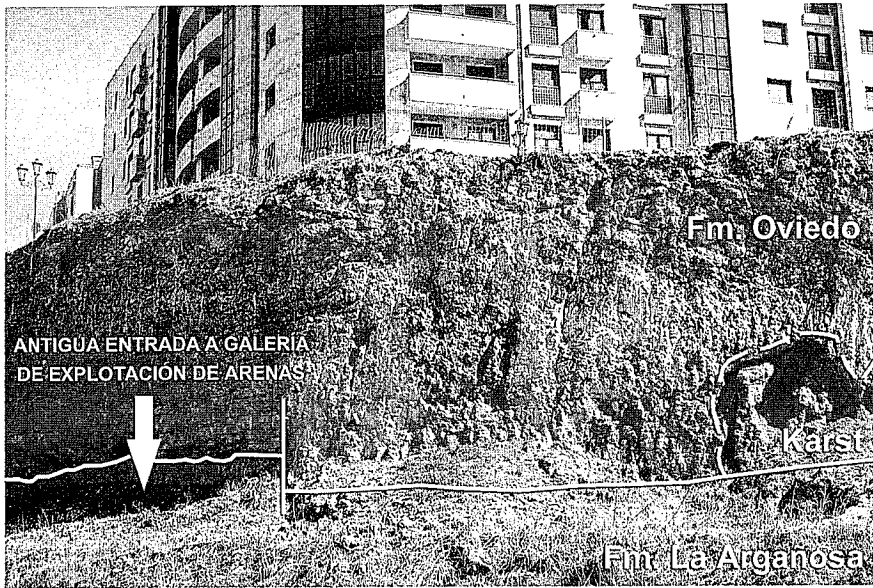
Fig. 2.- Talud en La Ería donde se observan evidencias kársticas en el contacto entre las dos formaciones (A en Fig. 1)
