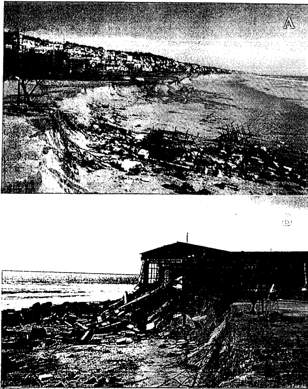
Figura.6.- Fotografías de los destrozos causados por el temporal de Febrero de 1996. (A) Pistas de tenis del Club Náutico, estación 1 y, (B) Edificio del Club Náutico, estación 2.
